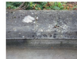
Die Randsteine sind substanzmäßig in gutem Zustand. Sie weisen einen Biofilm aus Algen, Moosen und Flechten auf, die Oberfläche ist stellenweise leicht verkrustet.
